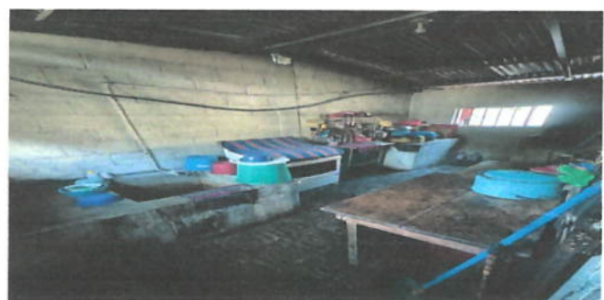
FOTO3: REPARACIÓN O SUSTITUCIÓN DE ÁREA DE COCINA
