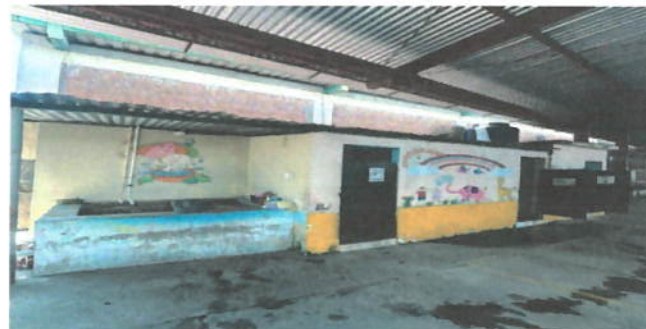
FOTO4: PINTURA EN MUROS INTERIOR Y EXTERIOR
