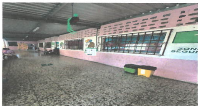
FOTO1: PINTURA EN MUROS INTERIOR Y EXTERIOR
